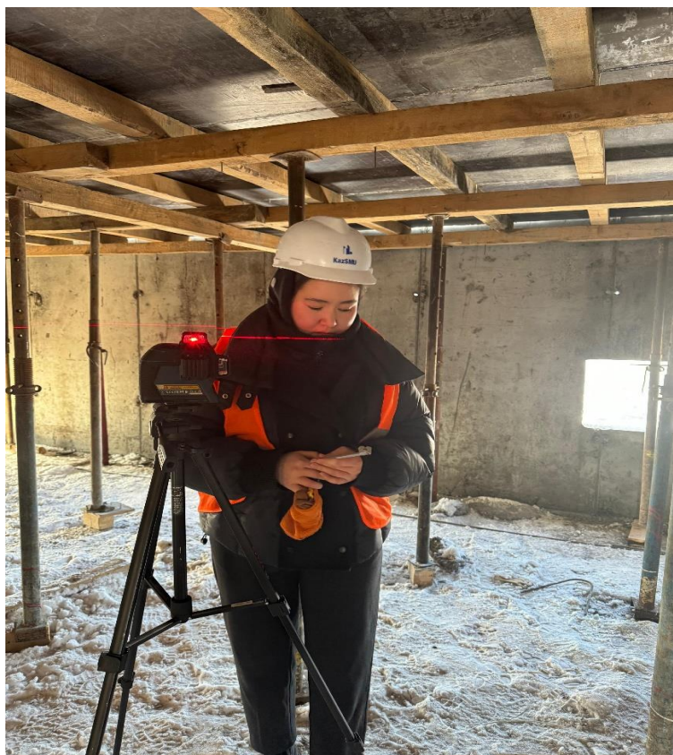
4.2-сурет – BOSCH GLL 3-80 лазерлік нивелирі
