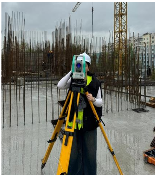
3.10-сурет – Геодезиялық бөлу жұмыстарын орындау кезеңі
